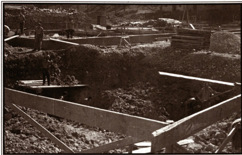
Začetek gradbenih del
