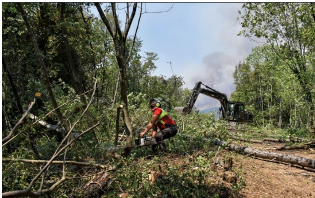
Slika 6: Dela na intervencijskih presekah so potekala ob pomoči gradbene mehanizacije Slovenske vojske (foto: B. Rantaša)
