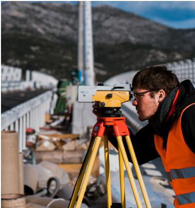
Foto : Ekipa geodetov med niveliranjem v prečni smeri (avtor fotografije Marin Bodulušić)
