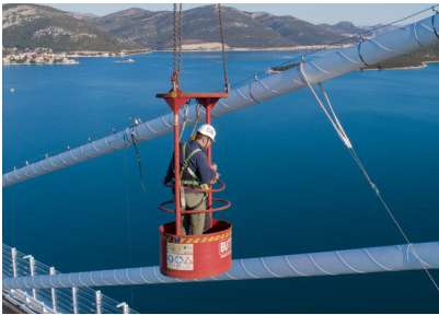
Foto: Priprava na vzbujanje poševnih zateg pri meritvah lastnih frekvenc in dušenja (avtor fotografije Marin Bodulušič)
