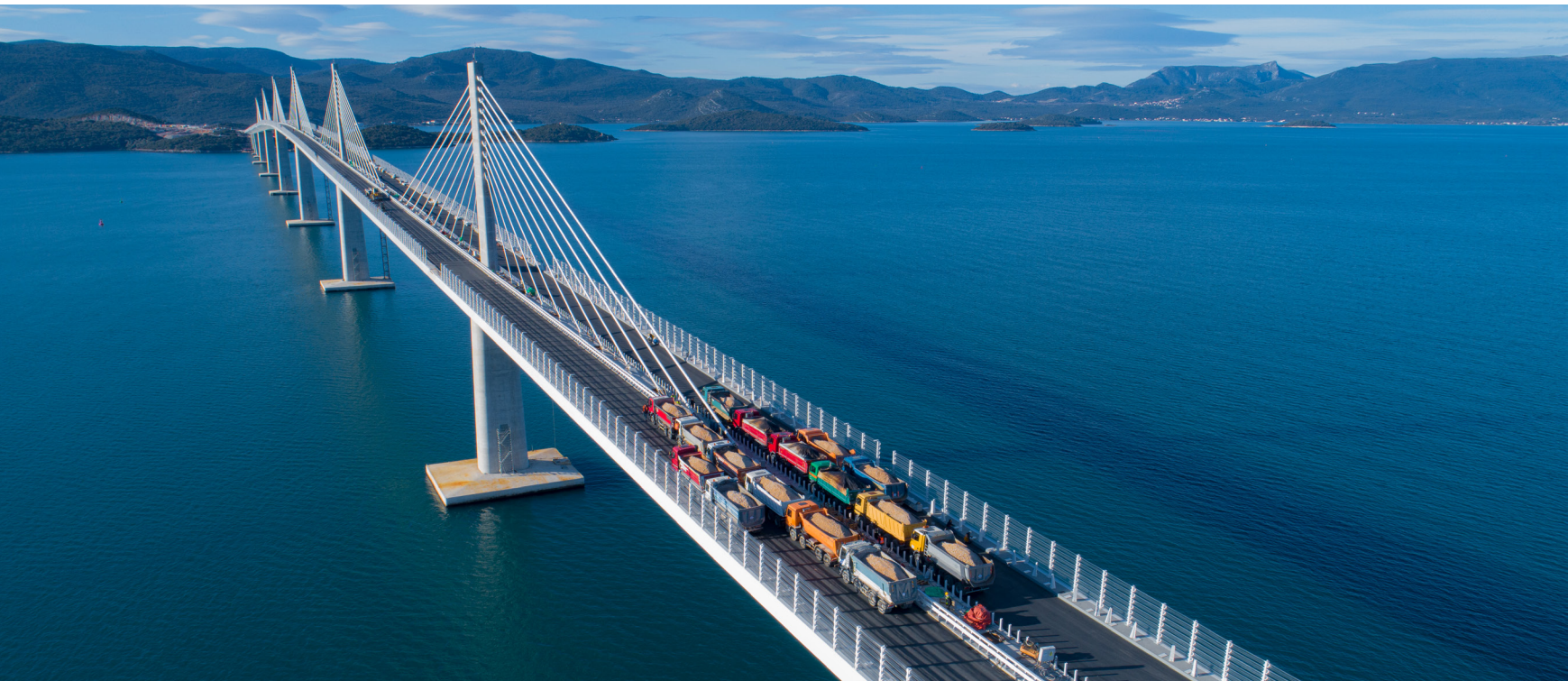
Foto: Polna obremenitev četrtega polja mostu (avtor fotografije Marin Bodulušič)
