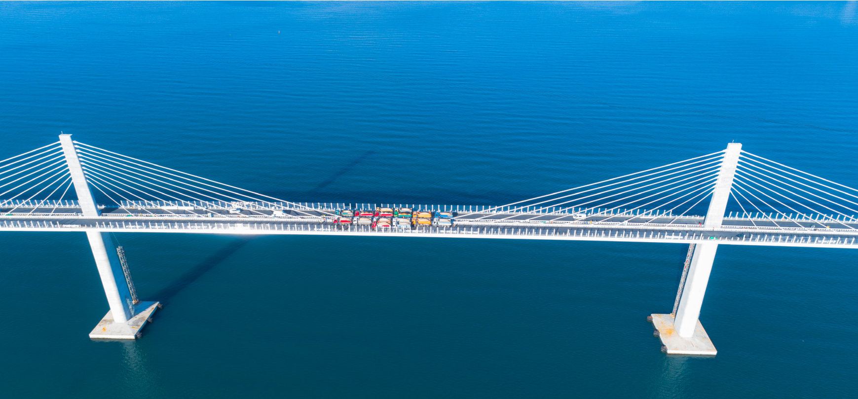
Foto spodaj: Polna obremenitev enega od glavnih polj mostu (avtor fotografije Marin)
