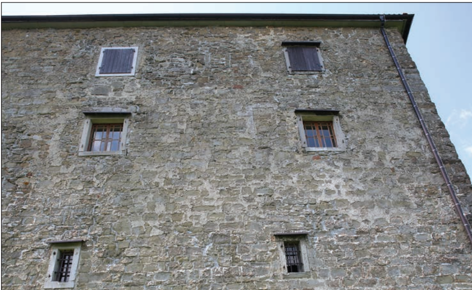
Sl. 12: Struktura kamnite zidave na vzhodni fasadi grajskega jedra (Igor Sapač, 2018).
