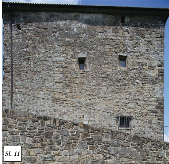
Sl. 10: Prezentirani odkopani ostanki zidov na zahodni strani grajskega jedra (Igor Sapač, 2018). Sl. 11: Struktura kamnite zidave na južni steni vzhodnega trakta grajskega jedra (Igor Sapač, 2018).
