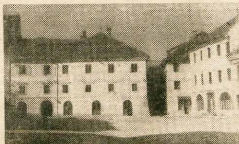
Obnovljen trg v Novem mestu
