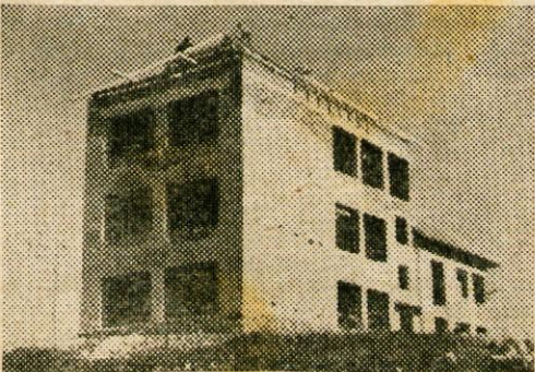
Šola na Dolžu med gradnjo
