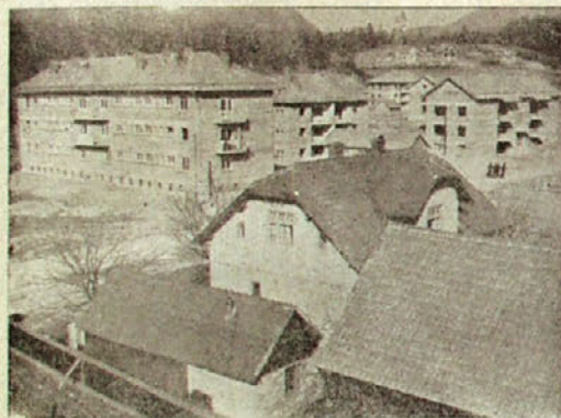
Del Novega Velenja v izgradnji
