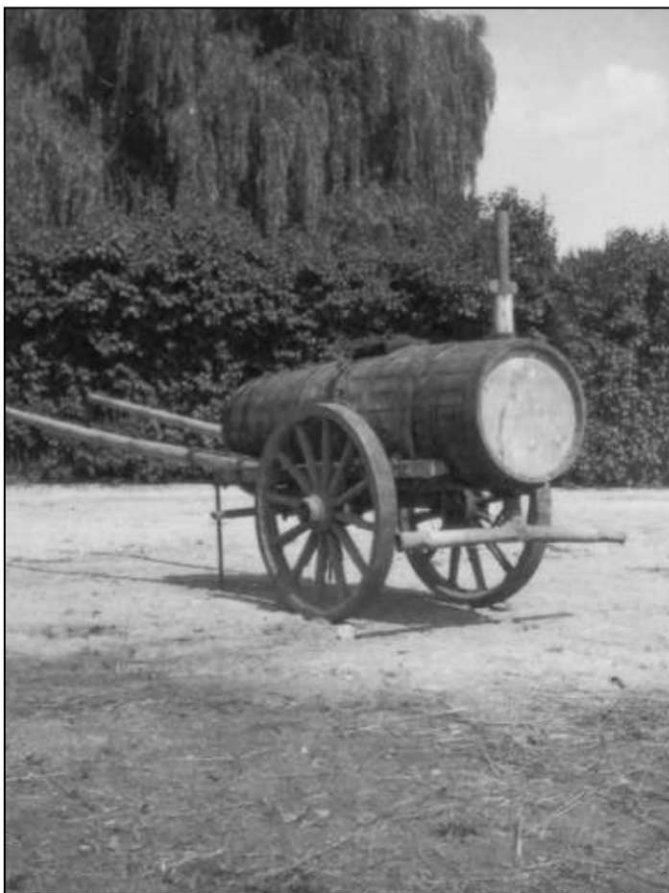
Slika 16: Nova Roblekova lesena cisterna za gnojnico, zalivanje z vodo in škropljenje hmelja okrog leta 1930 (vir: fotoarhiv OEIKA FF UL).
