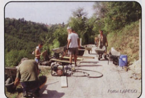
Obnova ceste na Debencu.
