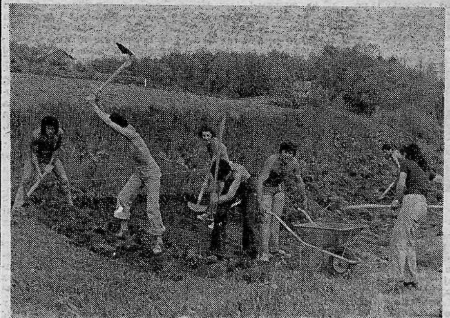
Pusta pobočja so zaživela, vodovod bo kmalu zgrajen.
