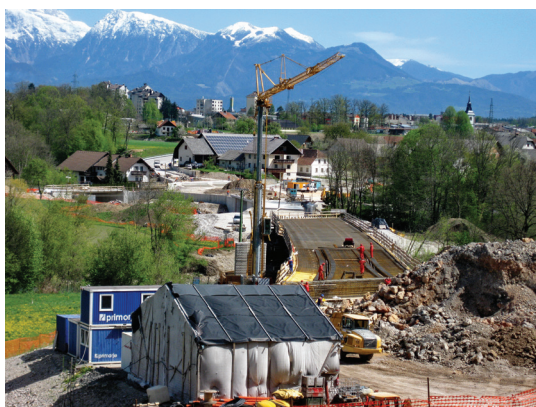
Gradnja mostu čez Soro na Suhi.
