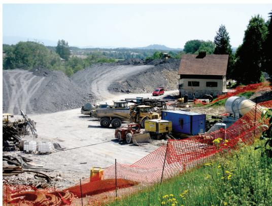
Gradbišče pri Kafolu.
