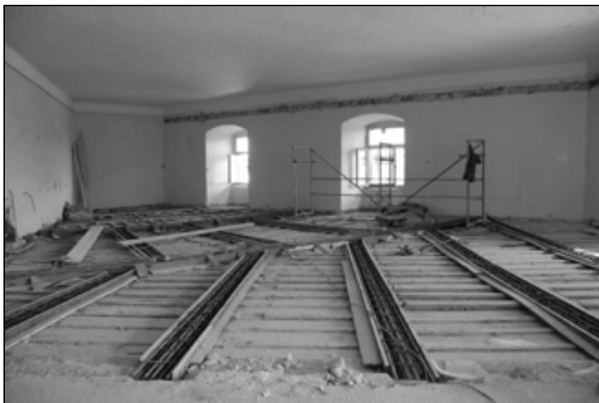
Sanacija medetažne lesene konstrukcije – lesenega tramovnega stropa med prvim in drugim nadstropjem vzhodnega trakta (foto: A. Železnik, september 2011).
