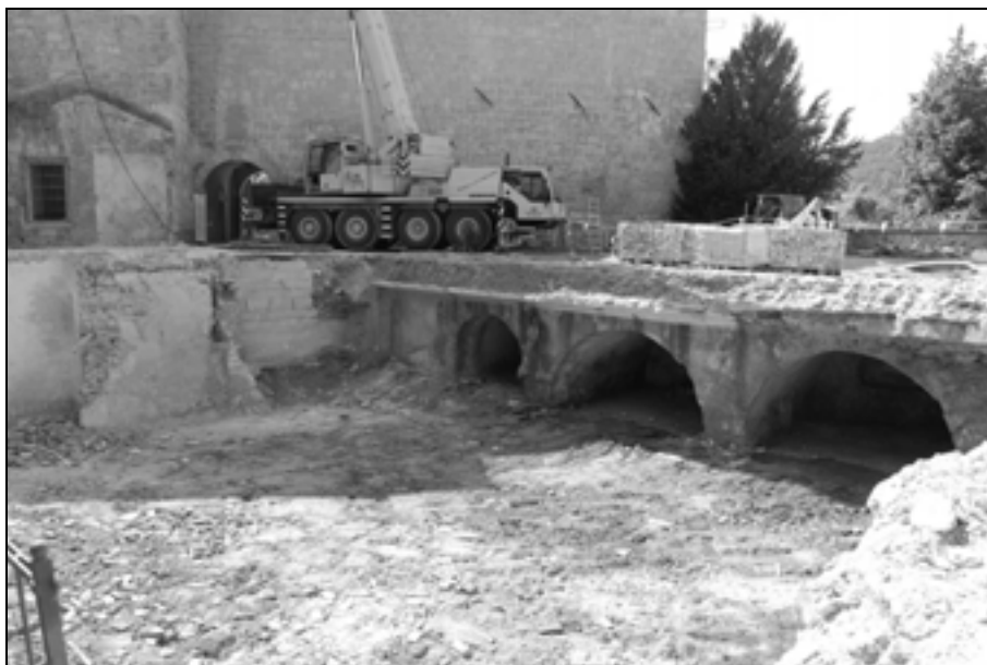
Kamniti triločni most po odstranitvi na njem pozidanih objektov (foto: A. Železnik, maj 2011).
