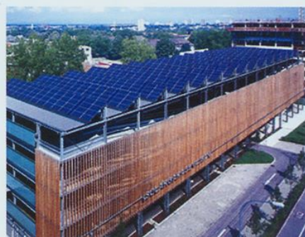
Fiksni omrežni sistem na strehi zgradbe v Nemčiji
