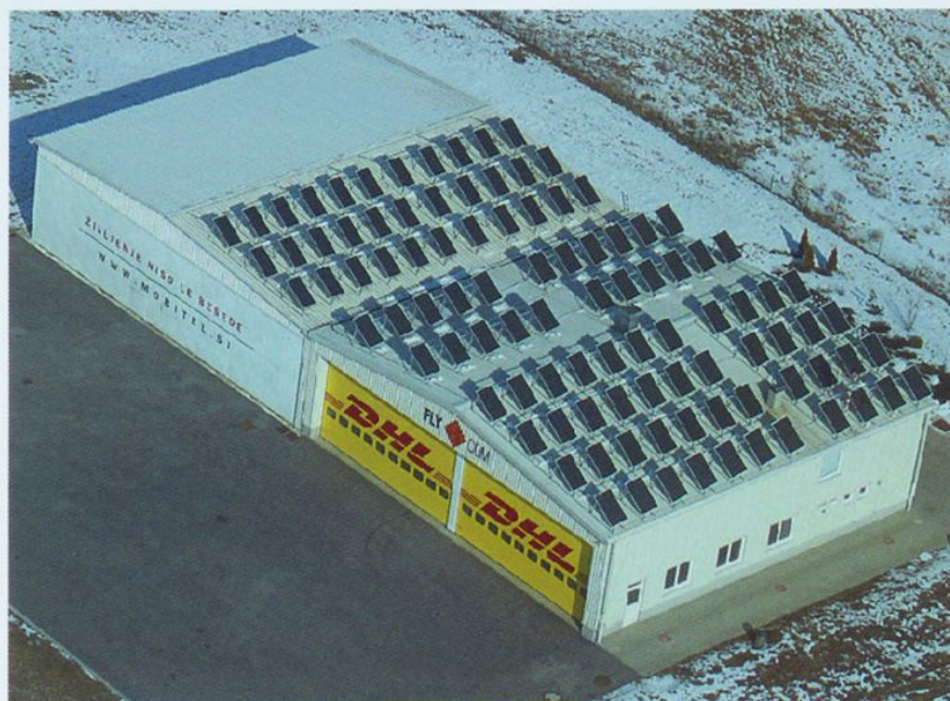
Sledilniki sonca na strehi hangerja podjetja Flycom v Lescah
