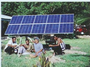
Črpališče za vodo, napajano s samostojnim sončnim fotonapetostnim sistemom
