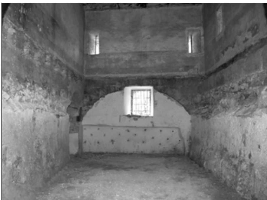
Južni prostor jugovzhodnega stolpa po odstranitvi oboka (foto: A. Železnik, junij 2011).
