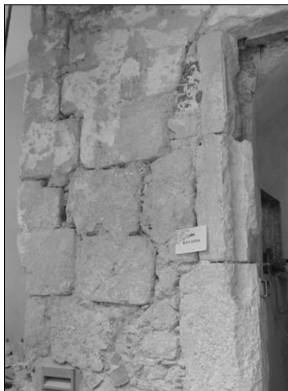
Romanska struktura zidave iz 12. stoletja na obvodnem stolpiču in na jugovzhodnem vogalu stavbe stolpaste oblike na severozahodni strani gradu (foto: Igor Sapač, 2005 in 2011).
