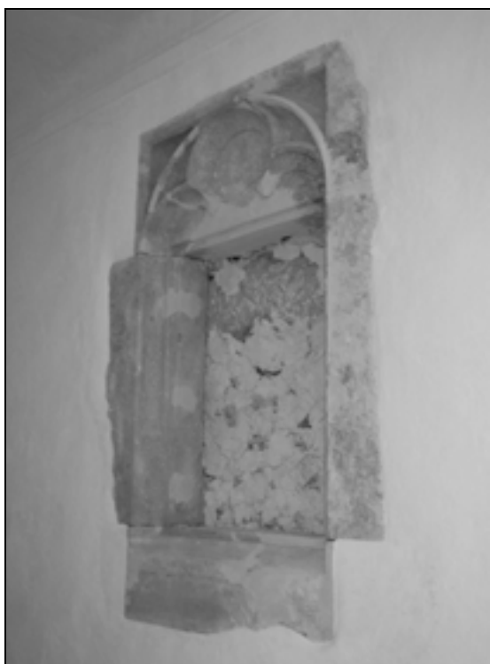
Poznogotsko okno s slepim krogovičjem, odkrito v drugem nadstropju zahodnega trakta (foto: A. Železnik, april 2012).
