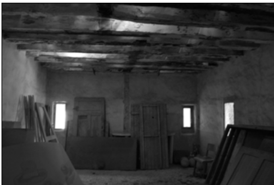
Južni prostor v pritličju jugovzhodnega stolpa pred prenovo (foto: A. Železnik, 2007).
