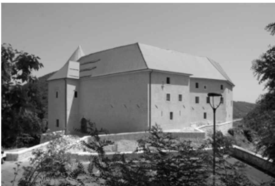
Predgradje z obrambnim jarkom in kamnitim mostom po prenovi (foto: A. Železnik, julij 2012).
