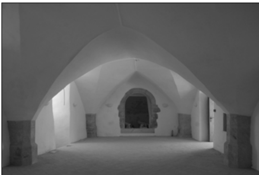
Prenovljeno pritličje zahodnega trakta (foto: A. Železnik, junij 2012).
