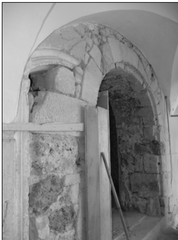
Velik polkrožno sklenjeni prehod v sedanjem pritličju severne stene romanskega palacija, prebit ob nekdanjem ožjem poznogotem portalu. (foto: Igor Sapač, 2011 in 2012).
