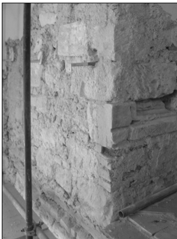
Stik dveh arkadnih slopov iz dveh razvojnih faz ob severovzhodnem vogalu notranjega grajskega dvorišča (levo) (foto: Igor Sapač, 2011). Bogato poznogotsko profilirano okensko ostenje, vzidano kot spolija v ostenju prehoda v prostor, ki je nastal v višini obočne konstrukcije romanske grajske kapele po njenem uničenju (desno) (foto: Igor Sapač, 2011).
