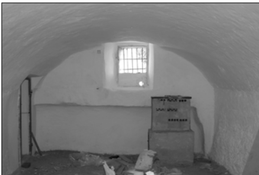
Klet južnega prostora jugovzhodnega stolpa pred prenovno (foto: A. Železnik, 2007).
