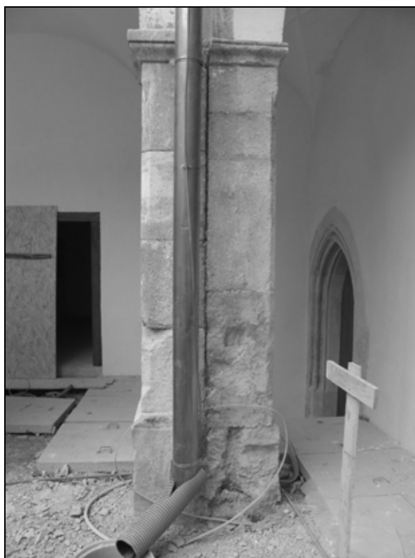
Stik dveh arkadnih slopov iz dveh razvojnih faz ob severovzhodnem vogalu notranjega grajskega dvorišča (levo) (foto: Igor Sapač, 2011). Bogato poznogotsko profilirano okensko ostenje, vzidano kot spolija v ostenju prehoda v prostor, ki je nastal v višini obočne konstrukcije romanske grajske kapele po njenem uničenju (desno) (foto: Igor Sapač, 2011).
