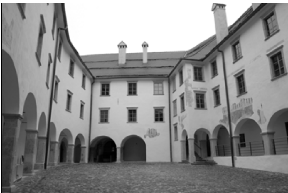
Dvoriščne fasade po restavratorskih posegih leta 2012 (foto: A. Železnik, julij 2012).
