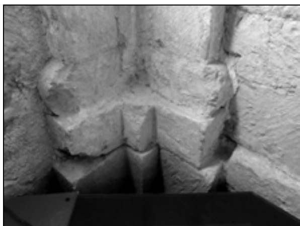
Sl. 28: Rajhenburg, romanska grajska kapela, baza severovzhodnega pilastra (foto: Mija Oter Gorenčič).
