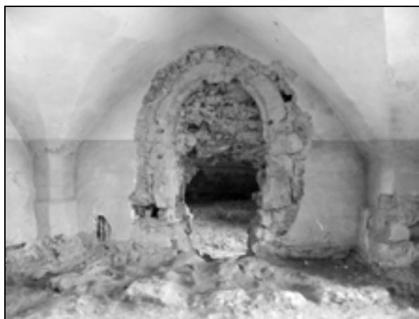
Slika 4. Portal v južni steni severozahodnega stolpa s kamnito substrukcijo (foto: M. Bricelj).
