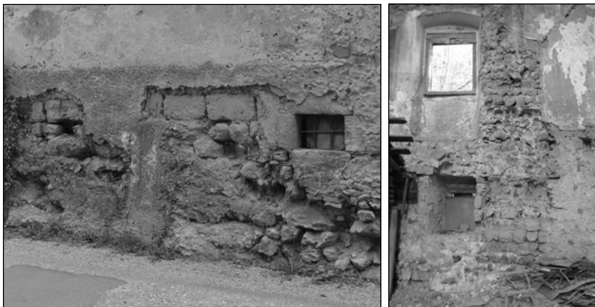
Romanska plastovita zidava v spodnjem delu severne stene prvotne stolpaste stavbe Turna na zunanjsčini (levo) in v notranjsčini (desno) (foto: Igor Sapač, 2012).
