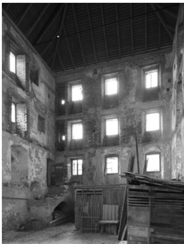
Notranjščina prvotne romanske stolpaste stavbe dvorca Turn po odstranitvi stropnih konstrukcij in predelnih sten ter po gradnji nove strehe (foto: Igor Sapač, 2012).
