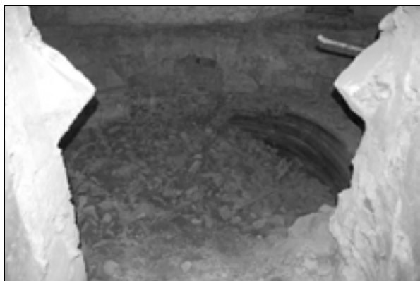
Kletna etaža okroglega stolpa po odstranitvi sekundarnega opečnega oboka in opečne obloge (foto: A. Železnik, maj 2011).
