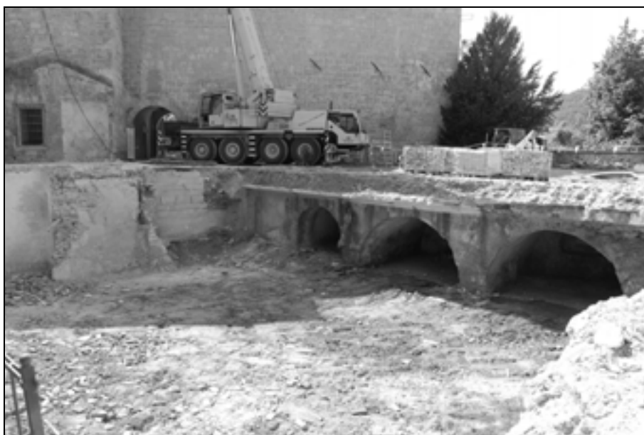
Kamnitni triločni most po odstranitvi na njem pozidanih objektov (foto: A. Železnik, maj 2011).
