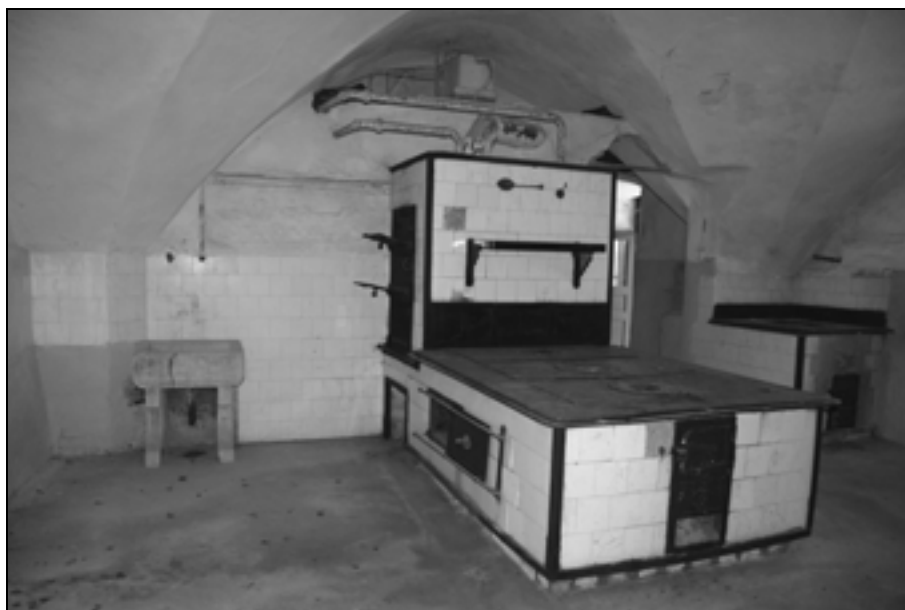
Pritličje zahodnega trakta pred prenovo (foto: A. Železnik, 2007).
