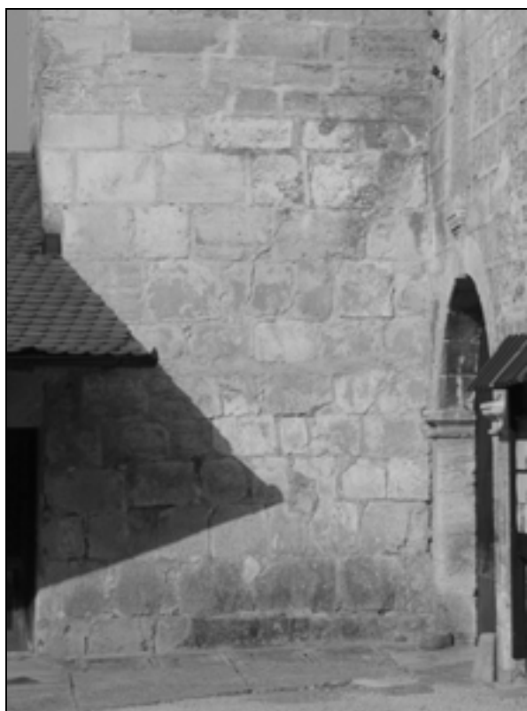
Romanska struktura zidave iz 12. stoletja na obvodnem stolpiču in na jugovzhodnem vogalu stavbe stolpaste oblike na severozahodni strani gradu (foto: Igor Sapač, 2005 in 2011).
