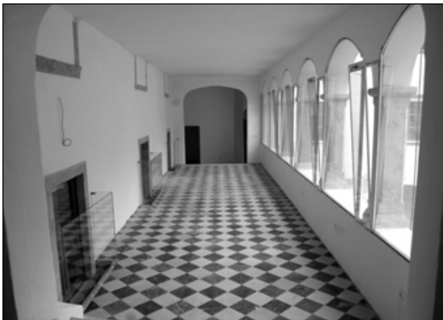
Arkadni hodnik v prvem nadstropju severnega trakta po prenovi (foto: A. Železnik, julij 2012).
