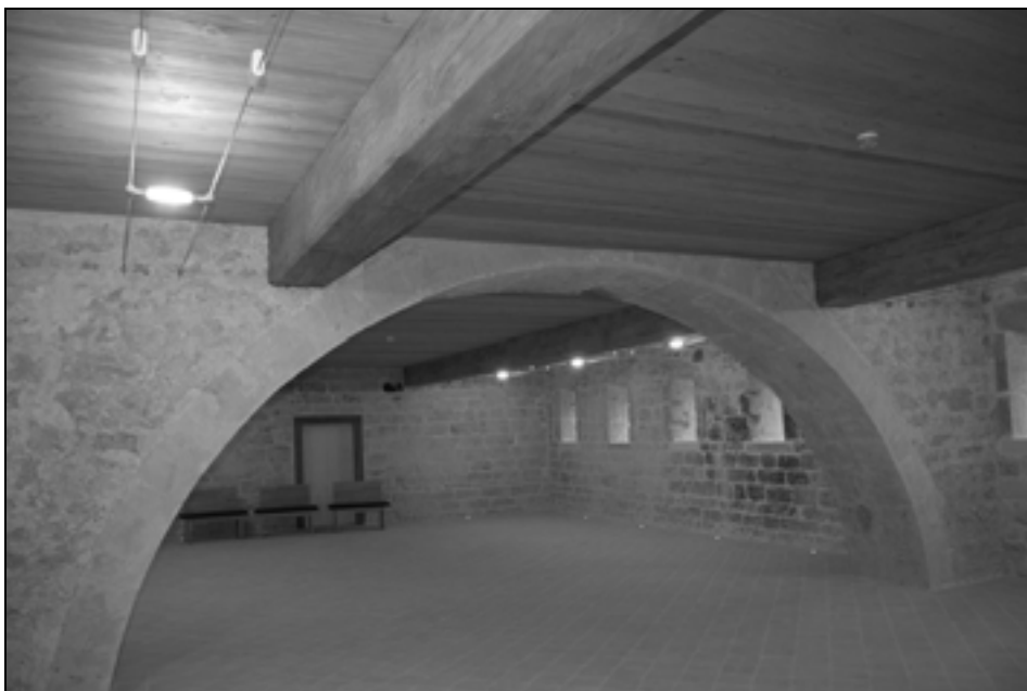
Prenovljeno pritličje južnega trakta (foto: A. Železnik, julij 2012).
