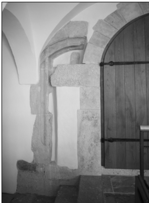
Velik polkrožno sklenjeni prehod v sedanjem pritličju severne stene romanskega palacija, prebit ob nekdanjem ožjem poznogotem portalu. (foto: Igor Sapač, 2011 in 2012).
