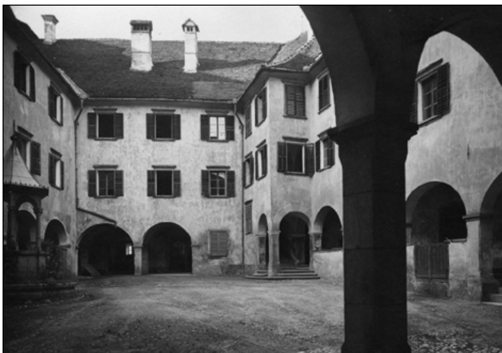
Pogled proti južni strani notranjega grajskega dvorišča z nastavkom cisterne za vodo pred drugo svetovno vojno (zasebna zbirka).
