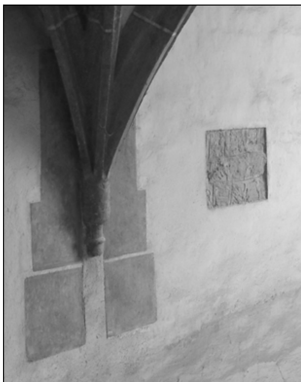
Prezentirana struktura romanske zidave iz 13. stoletja v zgornjem delu severne stene sedanje gotske kapele (levo) in odkrita lina na isti steni v višini tal sedanjega drugega nadstropja (desno) (foto: Igor Sapač, 2012).
