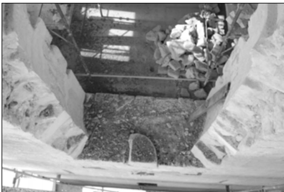
Pogled na apsidno z odlomljenim delom konzole po odstranitvi sekundarnih prezidav (foto: A. Železnik, oktober 2011).
