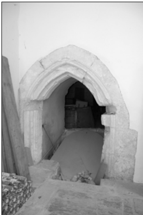
Šilastoločni paličasto členjen portal v zahodni steni vzhodnega trakta pred prenovo in po njej (foto: A. Železnik 2007, maj 2012).
