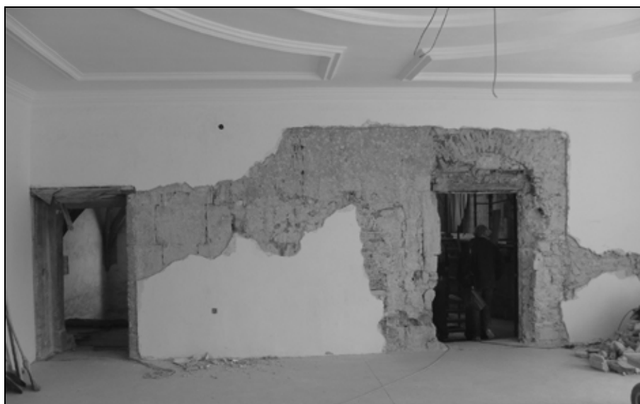
Romanski glavni portal v nekdanjem drugem nadstropju romanskega palacija (levo) in ostanki portala romanske grajske kapele (desno) med sondažnimi raziskavami marca 2012. Med portaloma so vidni odkriti ostanki romanskega ometa, ki so ga pozneje spet zakrili (foto: Igor Sapač).
