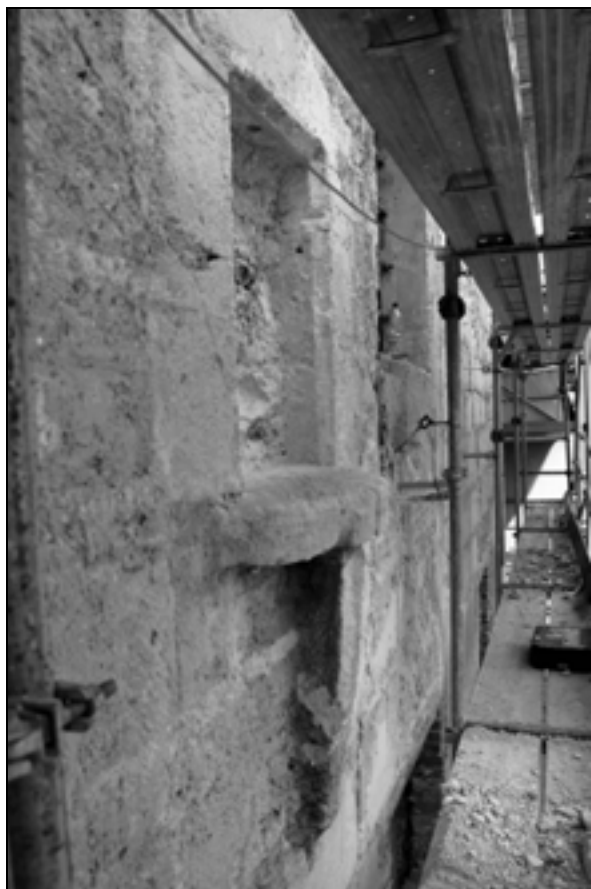
Odkrito okno s kamnito konzolo v drugem nadstropju zahodne fasade jugozahodnega stolpa (foto: A: Železnik, avgust 2011).
