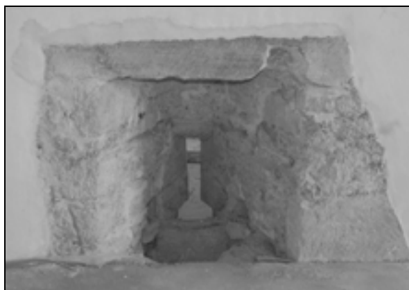
Strelnica v severni steni severnega prostora jugovzhodnega stolpa (foto: A. Železnik, marec 2012).
