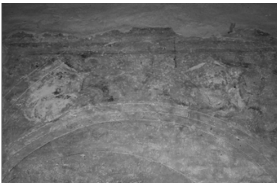
Grba na zahodni steni severnega prostora v prvem nadstropju vzhodnega trakta.
