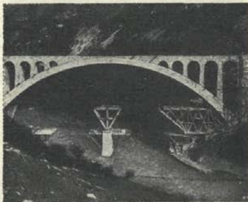
Solkanski most (stari), zgrajen iz nabrežinskega kamna.
