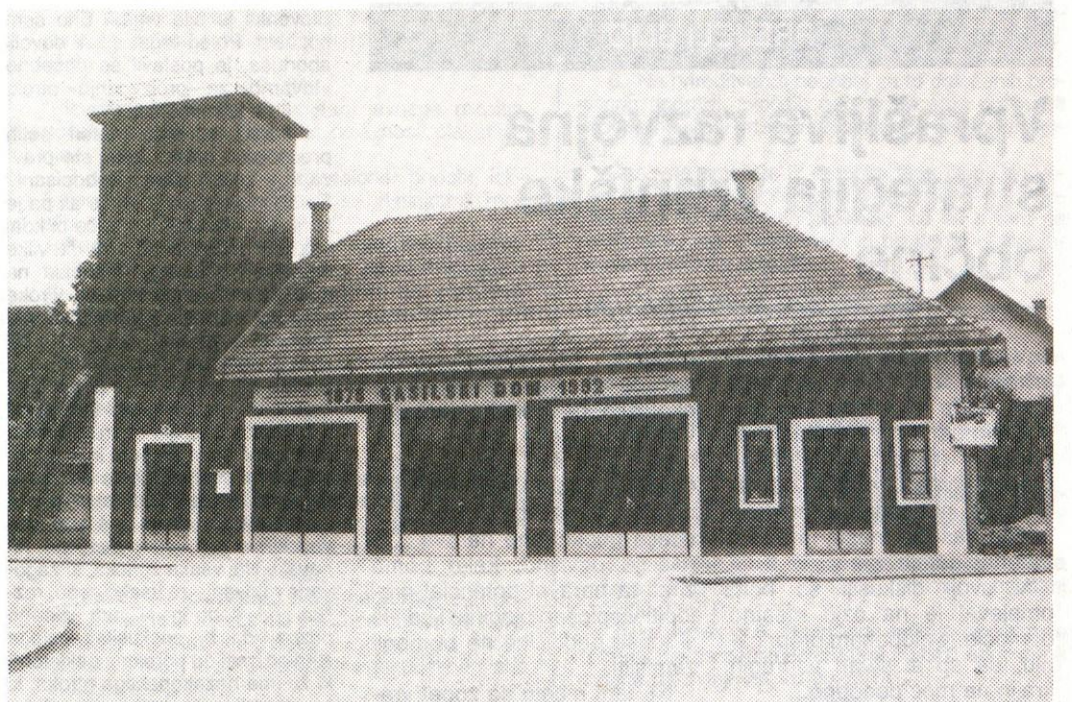
Vrhniški gasilski dom – obnoven
