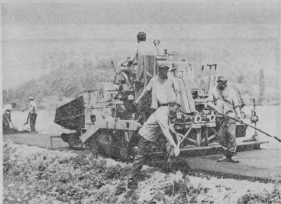
2,5 KM ASFALTIRANIH CEST — Minuli teden je Cestno podjetje Celje asfaltiralo na Polzeli, v Ločici, Orlovi vasi in v Parižljah 2,5 km cest. Sredstva so v veliki večini prispevali občani sami, del krajevne skupnosti, Tovarna nogavic Polzela in Garant Polzela. Posnetek je iz Orlove vasi pri Polzeli. Foto: T. Tavčar
