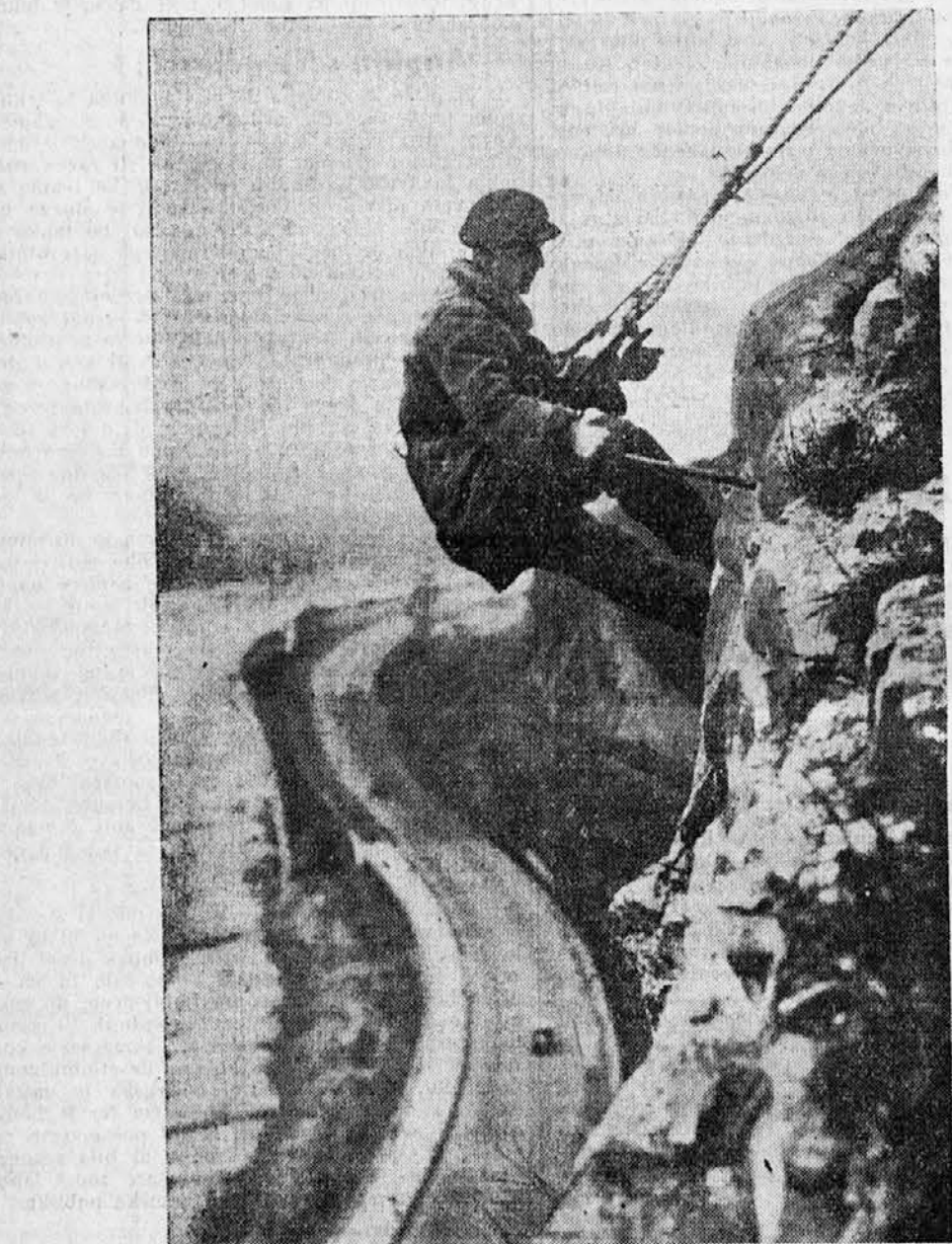
Nevarnosti dela. Takole razstreljujejo delavci skale nad avtomobilsko cesto v okolici Bristola, ki groze, da se bodo porušile nanjo.
