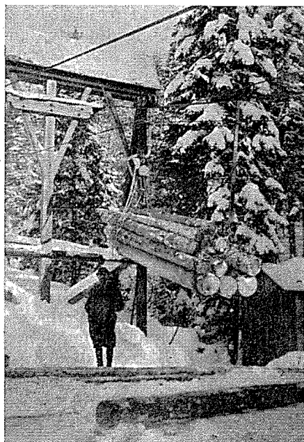
Spravljanje drv z vožnjo na sanch. Spuščanje hlovov po gozdni žični železnici.
