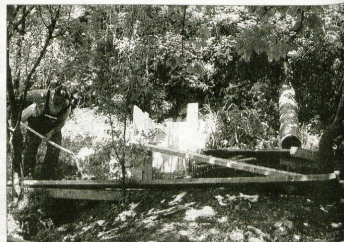
Izgradnja kanalizacijskih jaskov v strmem terenu je zelo zahtevna.
