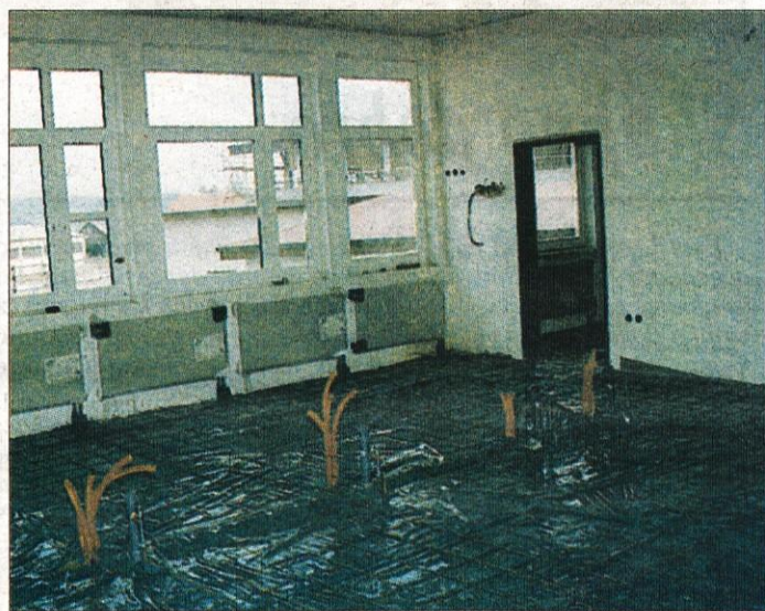
V tem prostoru bo zagotovo kakšen laboratorij, saj je že pripravljen za položitev tlakov in druge inštalacije.
