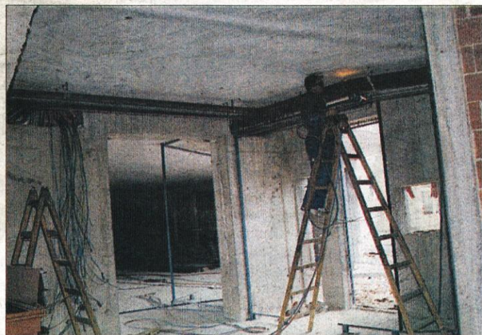
Prav v tem času opravljajo vsa inštalaterska dela (elektrika, vodovod, centralno ogrevanje).
