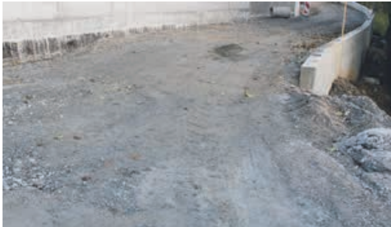
Cesta na Koreni tik pred asfaltiranjem.
