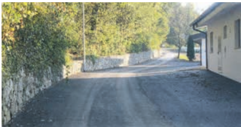
Določene dele ceste so na novo asfaltirali.
