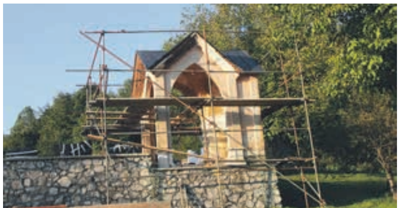
Obnovitvena dela grobnice na Lesnem Brdu.
