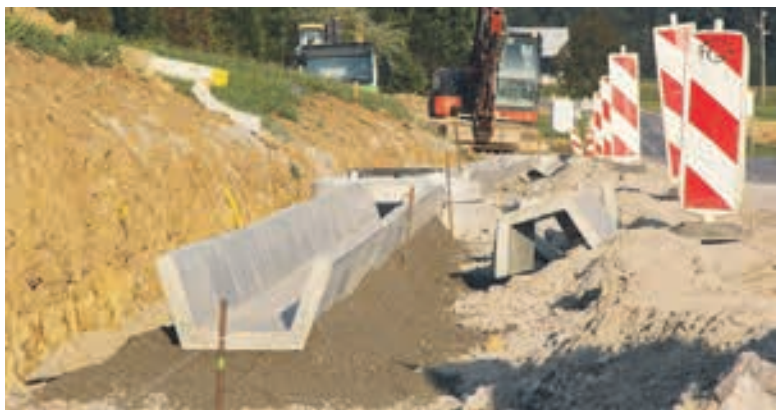
Urejanje odvodnjavanja meteornih voda ob glavni cesti med Horjulom in Dobrovo.
