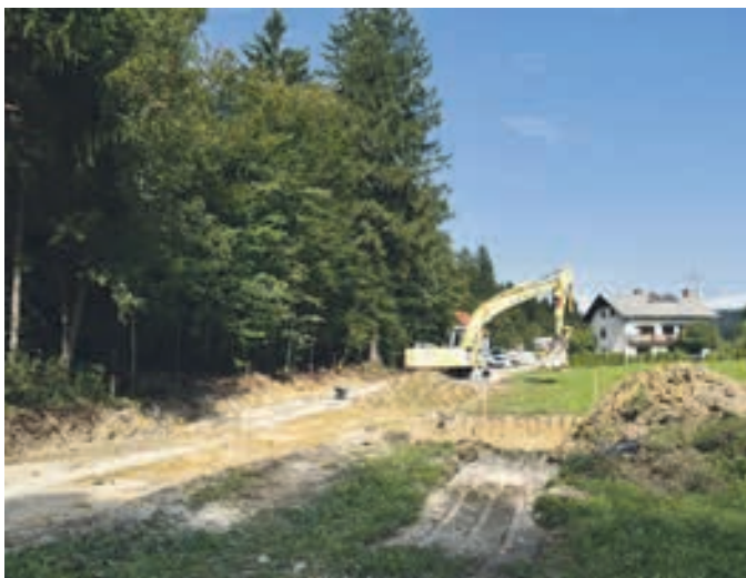
Prenova ceste Šujica-Stranska vas
