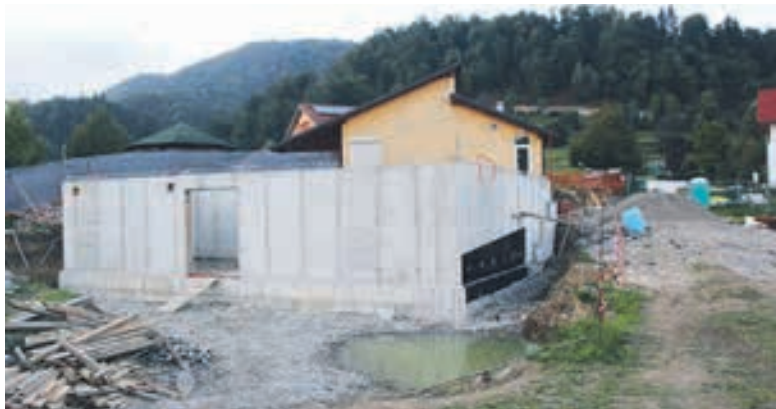
Kletni del prizidka k vrtcu v Horjulu je končan, sedaj sledi gradnja pritličja.
