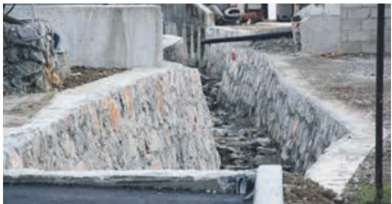
Zaključena so dela na vodotoku v Ljubojni.
