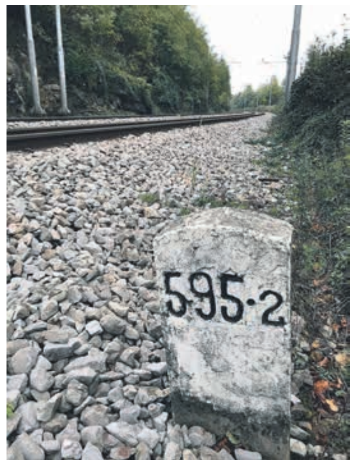
Temelji čuvajnice so pri km 595,2
