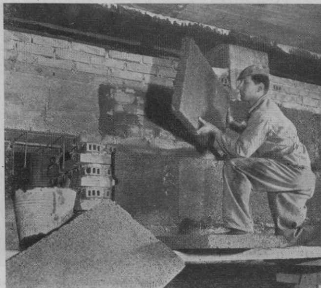
Montaža plutove izolacije — izdelek tovarne »PLUTAL«
