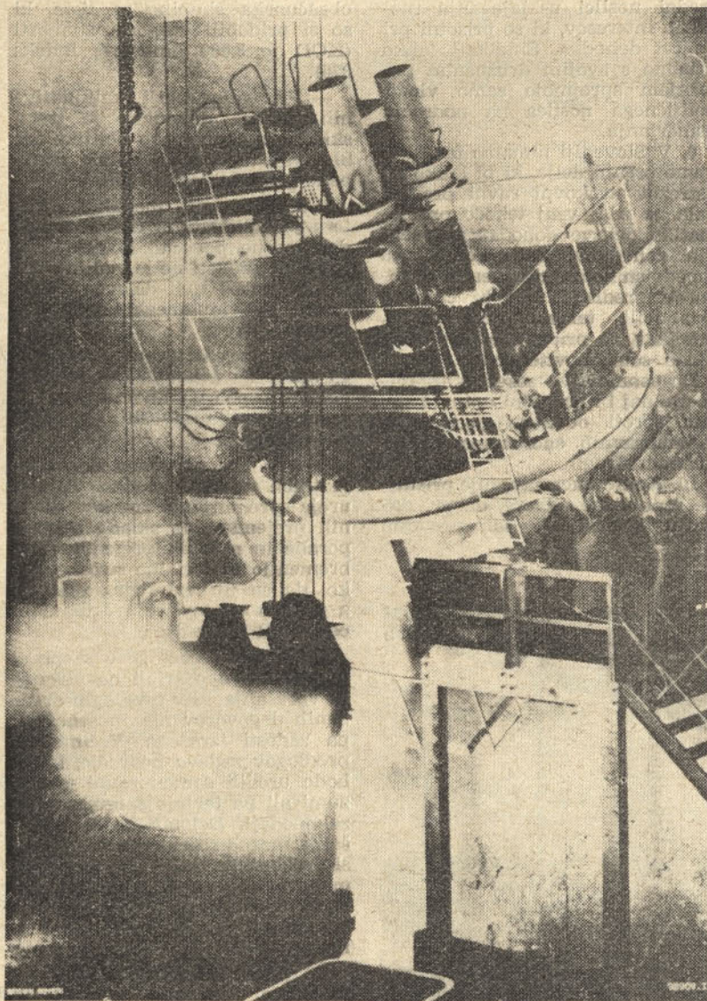
Pogled na 50 t elektro obložno peč pri izlivanju jekla.
