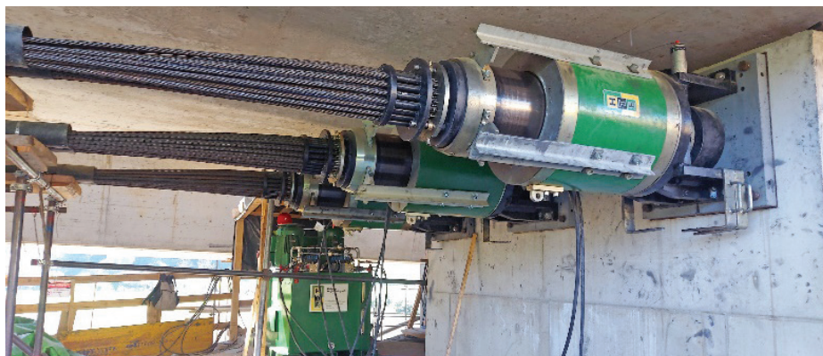
Slika 5. Narivni hidravlični bati za vlečenje s kabli za prednapenjanje – 3x Hebetec H400 kapacitete 3x400 ton, 3x37 vrvi za prednapenjanje. Med gradnjo se postopoma menjajo vlečne palice Freyssibar z najprej dvema, nato pa s tremi t. i. »strand jacki«.
