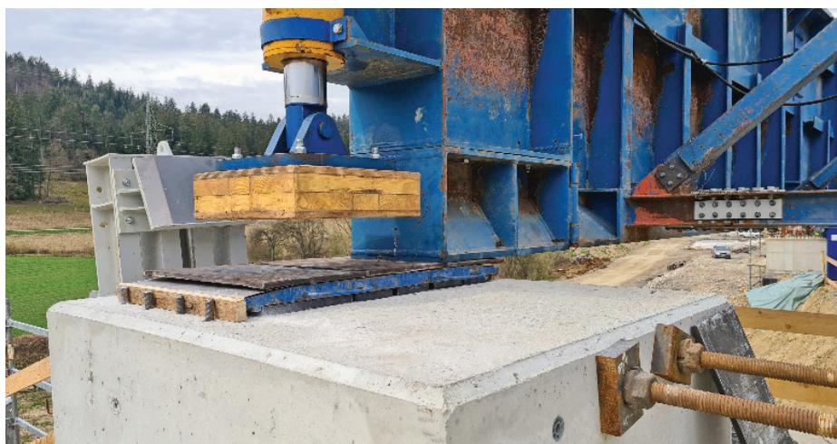
Slika 4. Prvi prehod levega kljuna na steber – vidni osnovni elementi narivanja: začasno drsno ležišče, teflonske drsne plošče, bočno vodilo, kljun za narivanje z dviznimi bati za dvig povešene konzole na steber.
