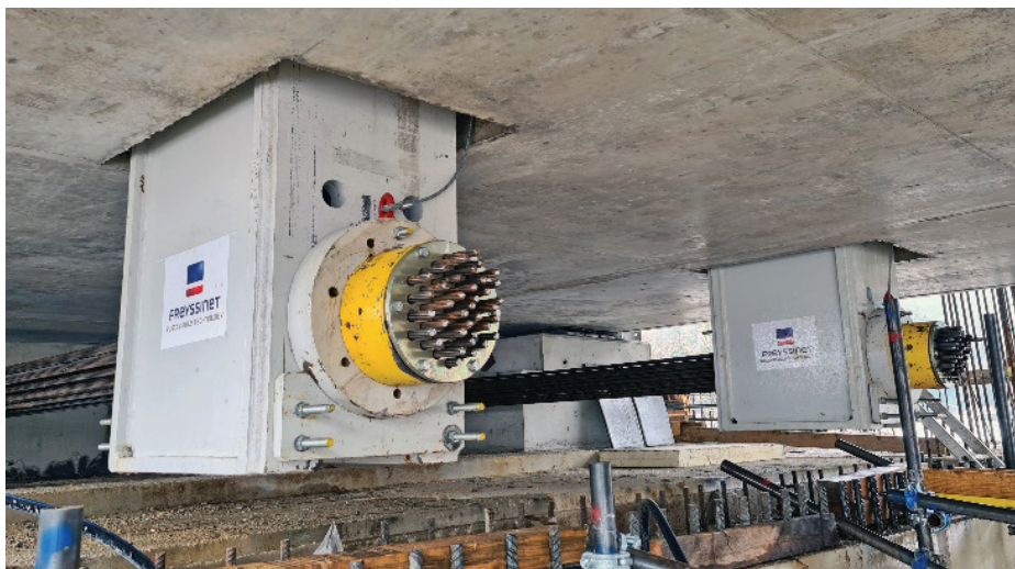
Slika 6. Vnos vlečne sile v prekladno konstrukcijo – na sliki dva vlečna trna dolžine 4 m in teže 3 tone, v katera se vpenjajo snopi vlečnih jeklenih vrvi.
