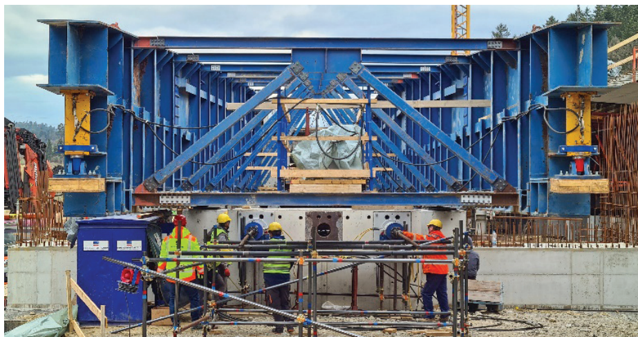
Slika 3. Narivanje 1. takta levega objekta – začetna narivanja z dvema votlima batoma kapacitete 2x150 t z vlečnima navojnima palicama Freyssibar B50.
