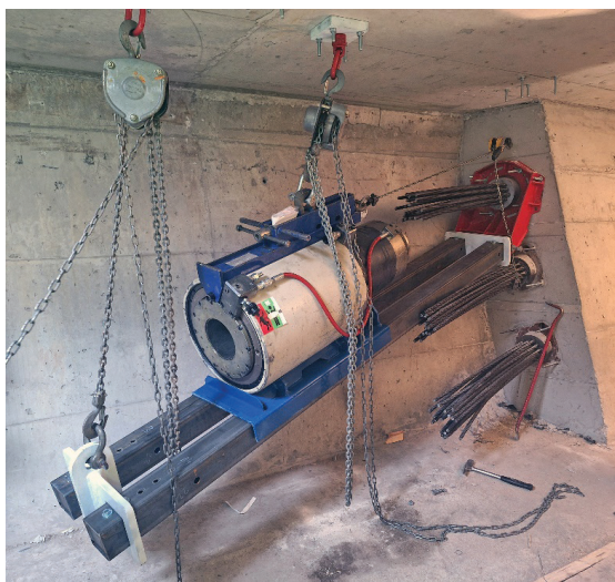
Slika 11. Vgradnja in napenjanje kontinuirnih kablov v notranjosti prekladne konstrukcije po končanem narivanju.
