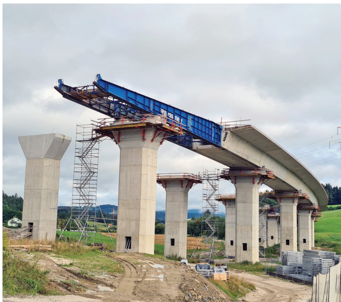
Slika 9. Narivanje 20. takta desnega objekta.
