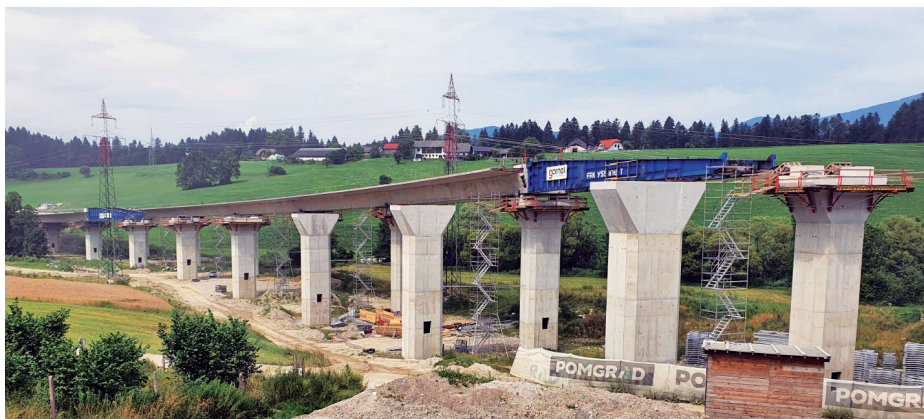
Slika 8. Narivanje 18. takta desnega objekta – gradnja levega se je pričela z zamikom, zato v tej dirki velikanov zaostaja.
