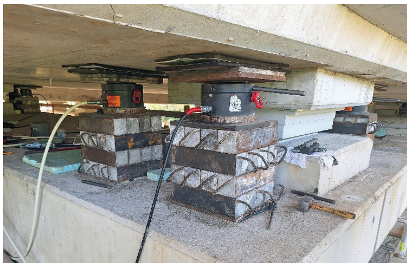
Slika 12. Vgradnja stalnih ležišč.
