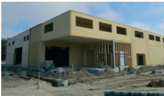
Slika 12: Poslovno – skladišni leseni masivni objekt v industrijski coni v Komendi, 2010.
