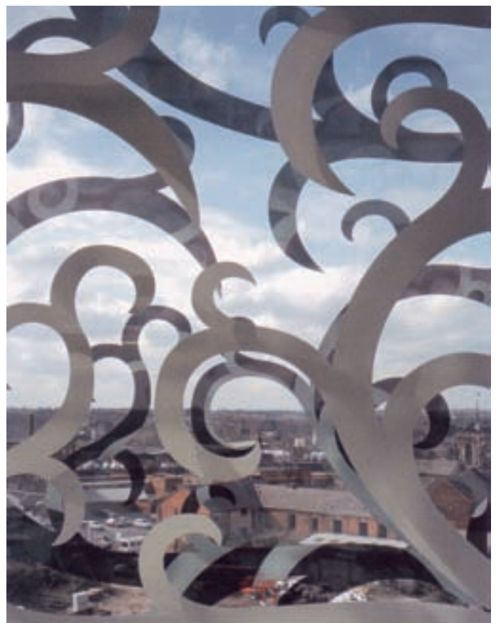
Slika 5: Tehnologija digitalnega tiska keramičnih delcev na steklo omogoča poljubno oblikovanje fasadne površine in zagotavlja trajnost tiskanega vzorca (John Lewis Department Store; Foreign Office Architects, London, 2008) [Pell, 2010: 99].
