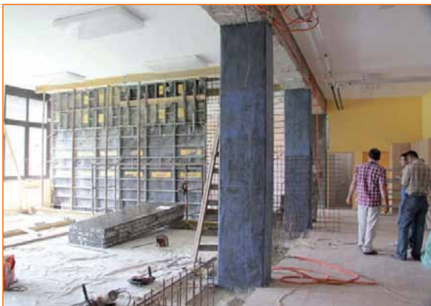
Stebri po sanaciji.
