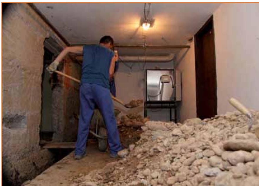
V kleti smo opravljali sanacijo do temeljev.
