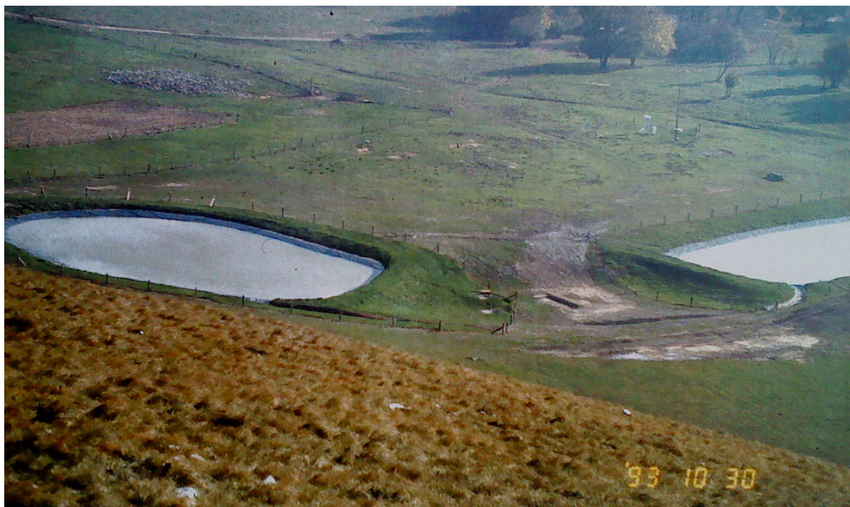
Slika 3.21: Vodna zbiralnika na planini Vremščica, napolnjena do nivoja prelivnega kanala. Na spodnjem delu slike je dobro vidna površina (80 % padec), iz katere zaradi skalovite in kamenite matične podlage ni bilo odtoka (Matičič, 2012)
