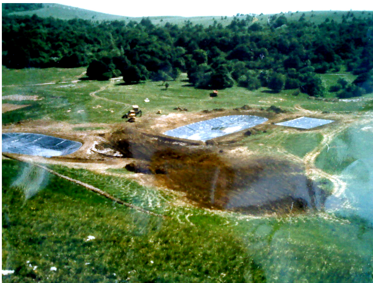
Slika 3.24: Pogled na vodna zbiralnika na Vremščici v času gradnje (Matičič, 2012)
