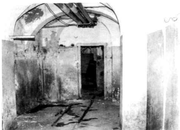
Grajski prostori v kleti severnega trakta ob prenovi za konservatorsko delavnico
