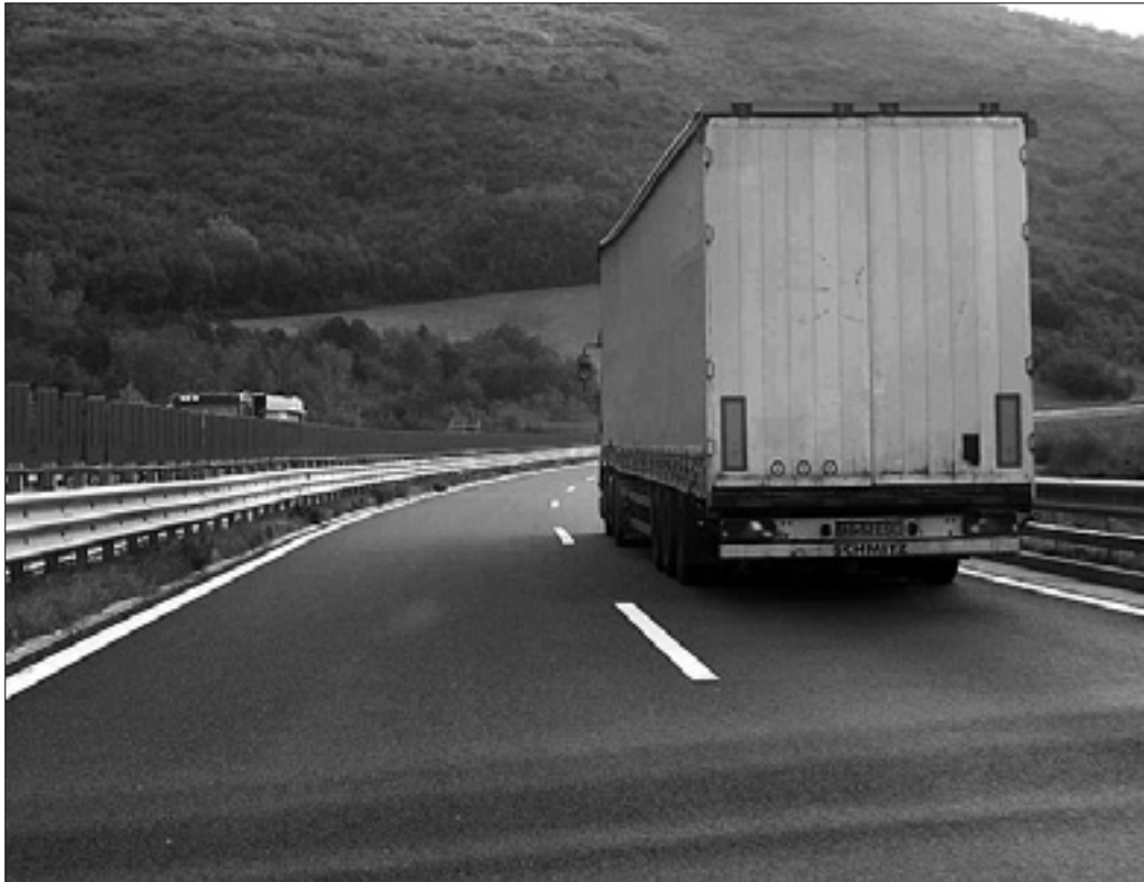
Odsek hitre ceste čez Rebrnice
