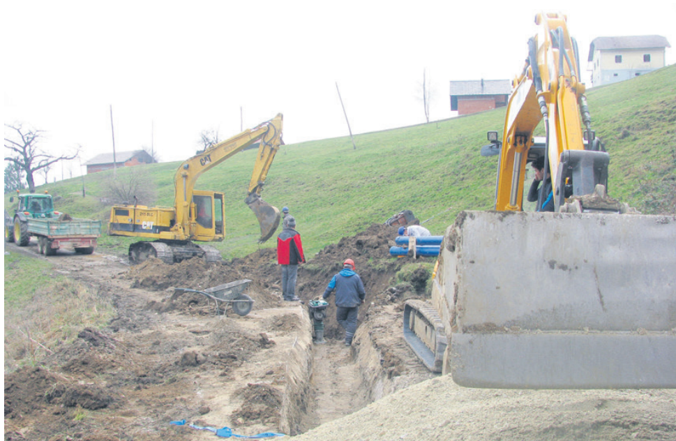
Stroji so na terenu zabrnili konec leta 2013, izvajalec je delo končal prej kot v letu dni, in sicer že oktobra 2014. Projekt so z odprtimi rokami sprejeli tudi prebivalci, ki so na voljo dali svoja zemljišča, poleg tega so pokazali zvrhano mero potrpežljivosti, ko so se ceste spremenile v gradbišča.
