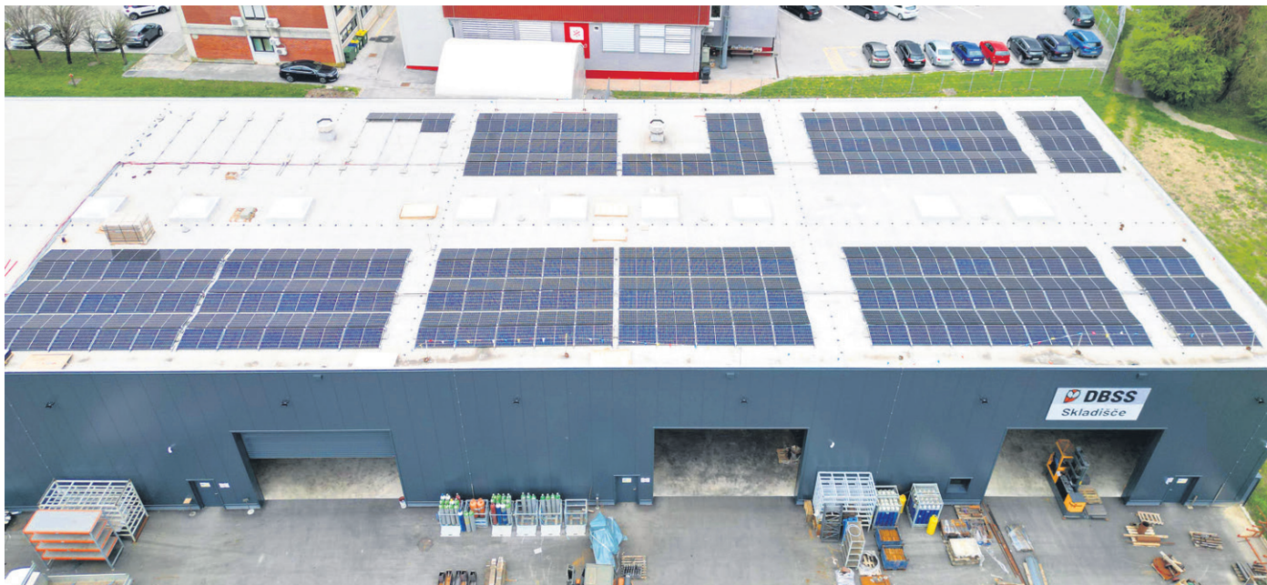
Med večjimi letošnjimi projekti družbe HTZ je tudi gradnja sončne elektrarne na strehi proizvodne hale velenjskega podjetja DBSS. (Foto: arhiv HTZ)
