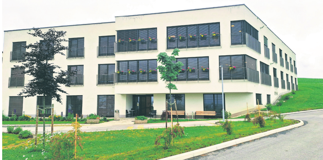
Prizidek na severni strani zgradbe so Polzelani dokončali tik pred začetkom epidemije. V njem so samo eno- in dvoposteljne sobe.
