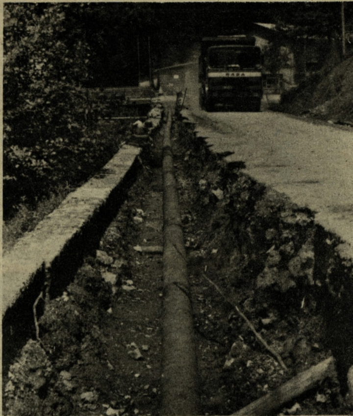
SANACIJA CESTE KAMNOLOM - LIBOJE - Od kamnoloma nad Libojami do Liboje nekaj časa urejujejo cesto. Asfaltno cestišče je bilo zaradi velikega prometa že povsem izrabljeno in ga bod o sedaj na novo asfaltirali.
