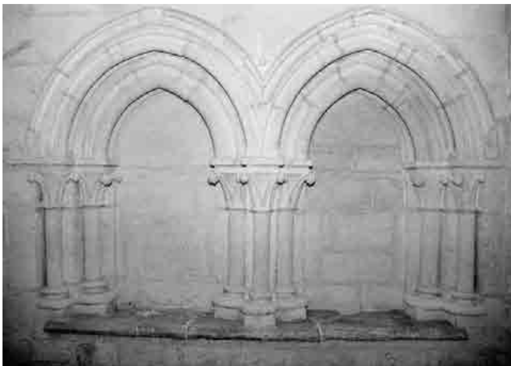
12. Špitalič, nekdanja ecclesia minor , sedilije na južni steni prezbitarija / Špitalič, former ecclesia minor , sedilia at the south wall of the presbytery
