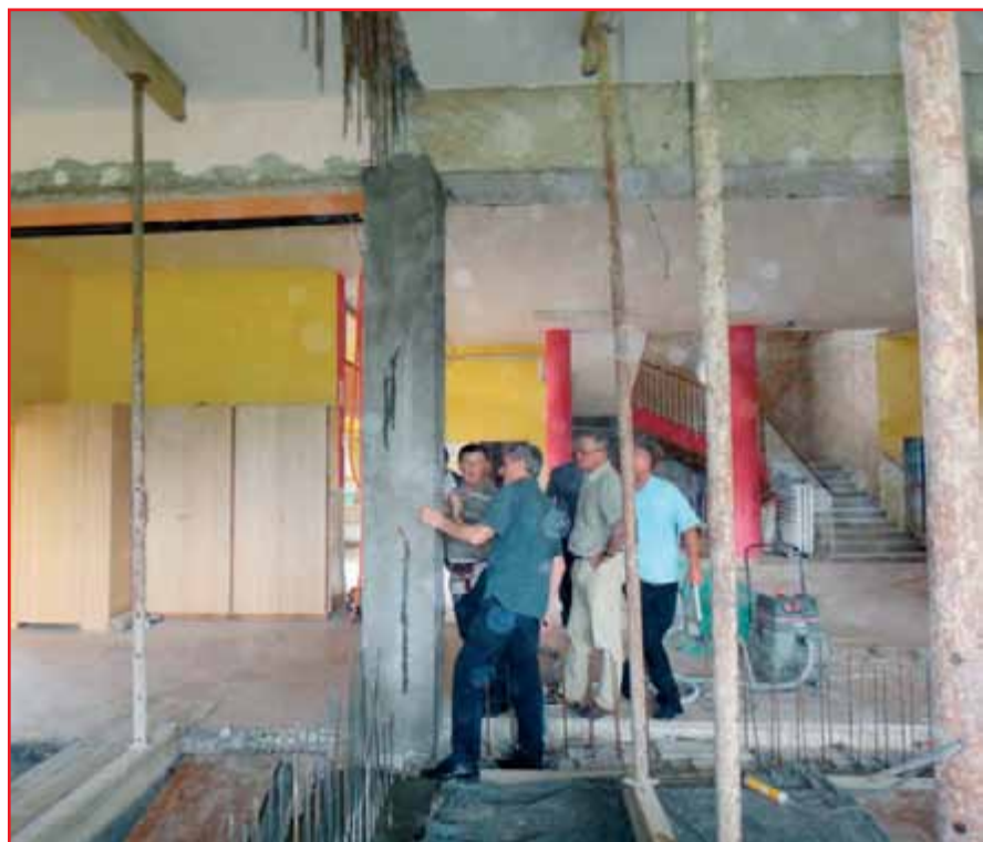
Nadzor izvedenega dela.
