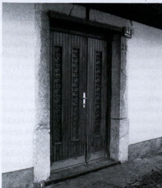
Preprost portal hiše na Šterngriču, sestavljen iz štirih pokončnih in enega prečnega klesanega kamnitega bloka. Tudi prag sestavljata dve kamniti plošči. Foto: Janko Rupnik
