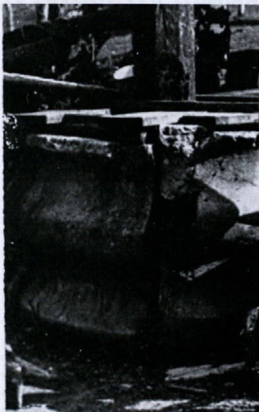
Zunanji del "šterne" pri Matjažu v Zavrattu, sestavljen iz štirih kamnitih klesanih delov, zgoraj je viden steber ročne črpalke.
