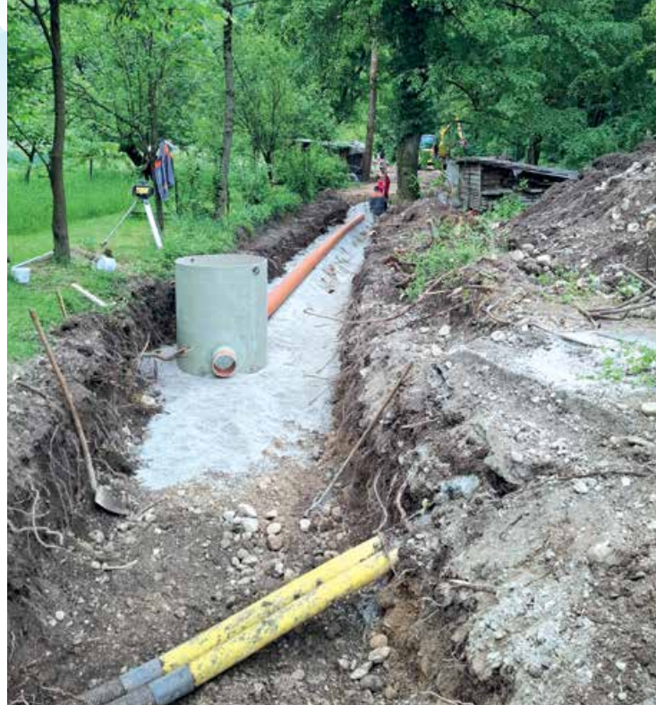
Izgradnja kanalizacije v Iški
