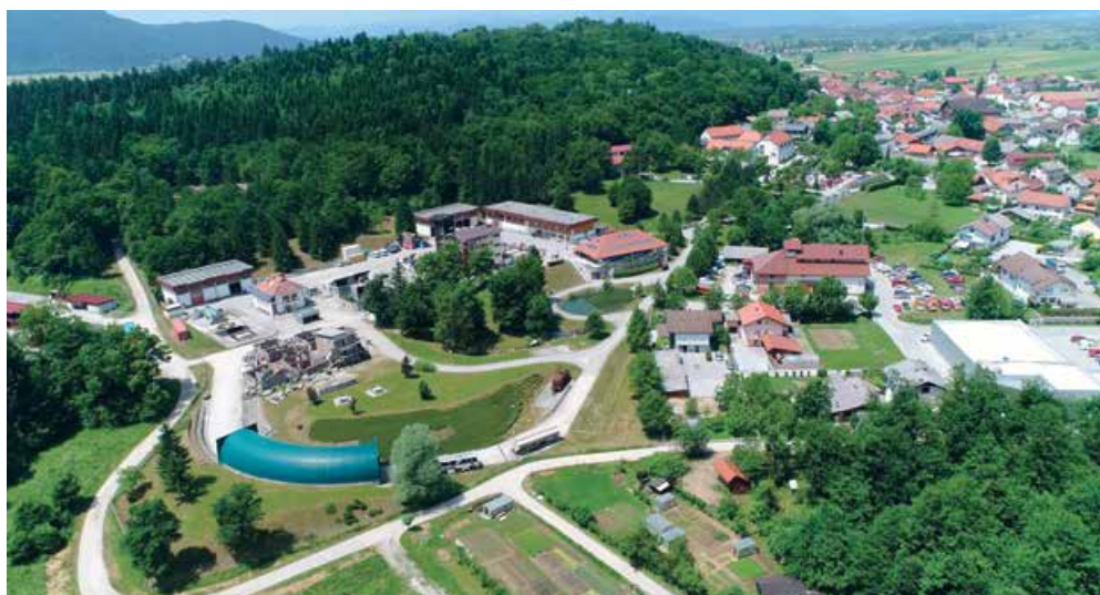
Pogled na infrastrukturo ICZR Ig iz zraka
