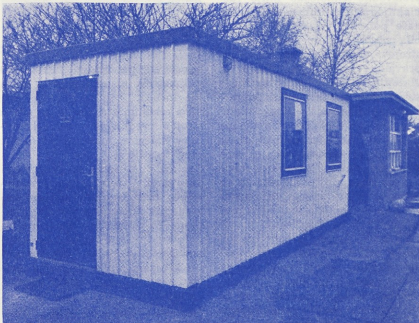
MOBILARO BLOK Avtoradgona na skladišču v Mariboru. V njem je tudi blagajna za drobni odkup in prodajo. Takšna oziroma nekoliko večja bloka sta tudi na skladišču v Lendavi in Črnomlju
