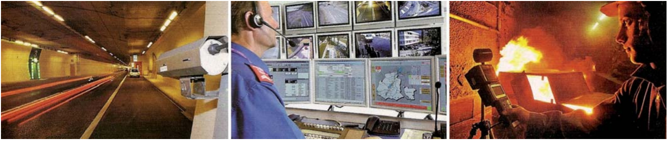
Najvarnejši predor na svetu: nadzorni sistem v Giswilu samodejno odkriva zastoje v prometu in dim (kar se občasno preverja tudi z gasilskimi vajami).
