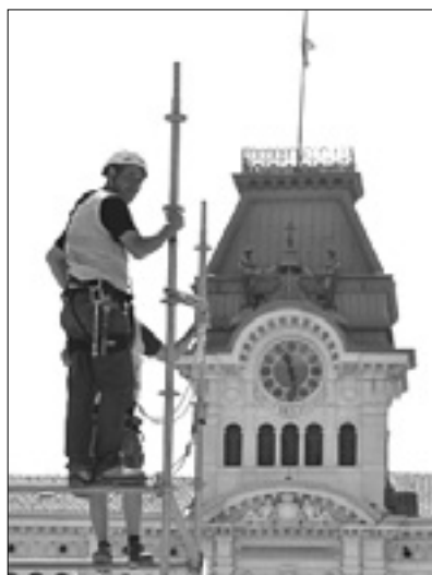
Delavec med gradnjo odra
