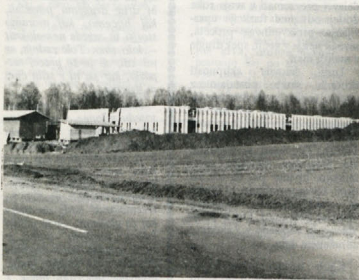
DO MAJA NAMREČ — Delo pri graditvi naše stavbe v Žakanju lepo napreduje. Transportno gradbeno podjetje zagotavlja, da bodo dela končana v roku, to se pravi do maja. Ljudje se že zanimajo za zaposlitev, okrog novogradnje pa je prodanih tudi že več parcel za gradnjo hiš. (Foto: Branko Herak)
