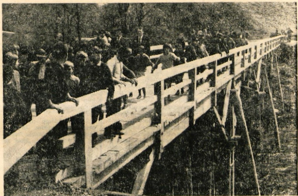
Prejšnji torek nekaj pred drugo uro je predsednik občinske skupščine Škofja Loka Zdravko Krvinja odprl nov most čez Savo, ki povezuje Suho z vasjo Hosta. Most je lesene konstrukcije, dolg 52 metrov. Zgradilo ga je splošno gradbeno podjetje Tehnik iz Škofje Loke v zelo kratkem času — v dveh mesecih. Od tega dne dalje pa je zaprt most v Puštal. Delo pri gradnji tega mostu bo odslej lahko potekalo nemoteno in hitreje. — Foto: F. Perdan
