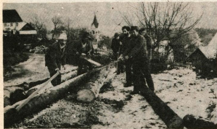
Za podaljšek strehe na gasilskem domu — Člani gasilskega društva Brezje pri Trzinu so prejšnjo soboto, 12. decembra, imeli udarniško. Pripravljali so les za streho nad prizidkom gasilskega doma. To jesen so namreč pri gasilskem domu zgradili prizidek, s katerim bodo za 6,5 m podaljšali dvorano doma, spodaj pa pridobili dve veliki garaži za shranjevanje avtomobila, brizgaln, orodja. — Foto: D. Dolenc
