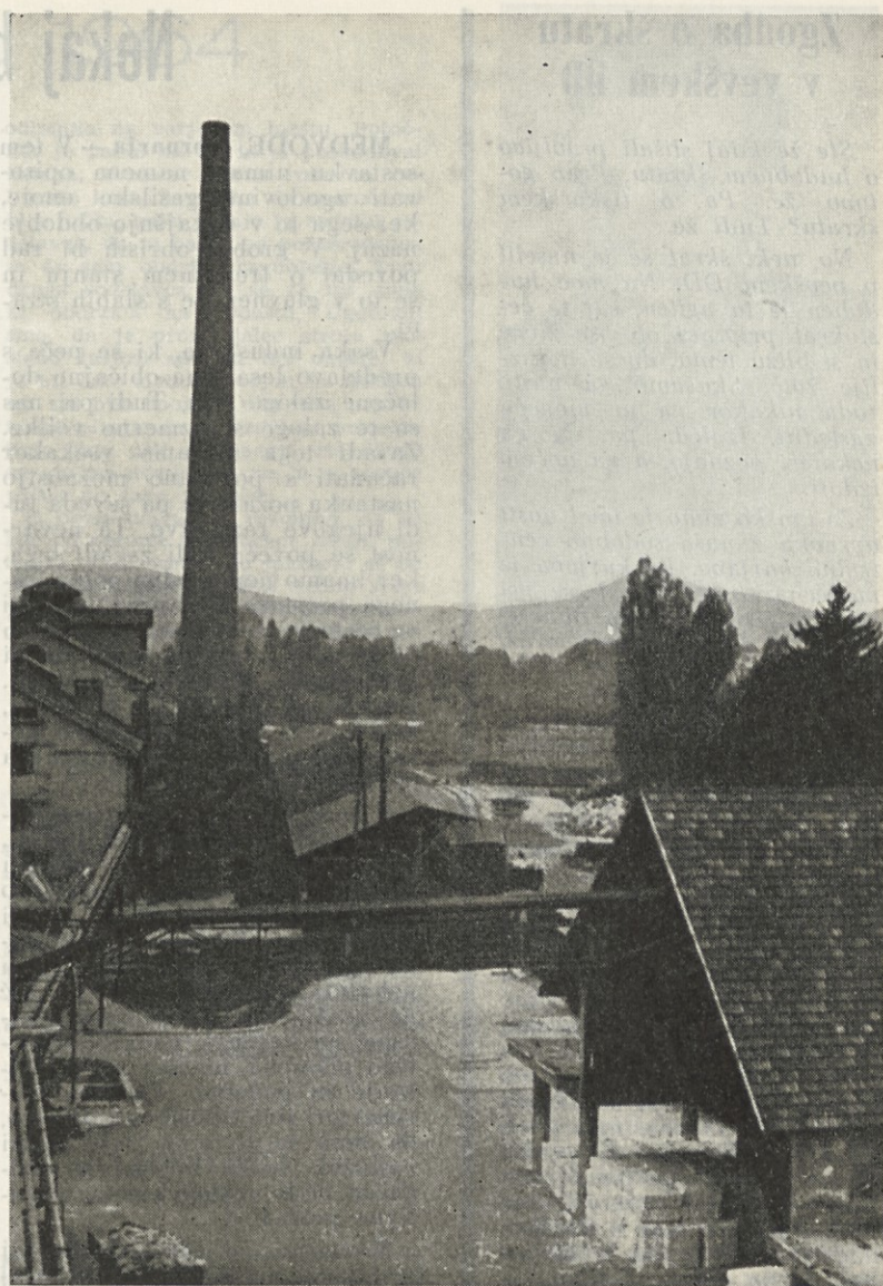
Pogled na zgradbo kalorične centrale in lopo za deponijo premoga
