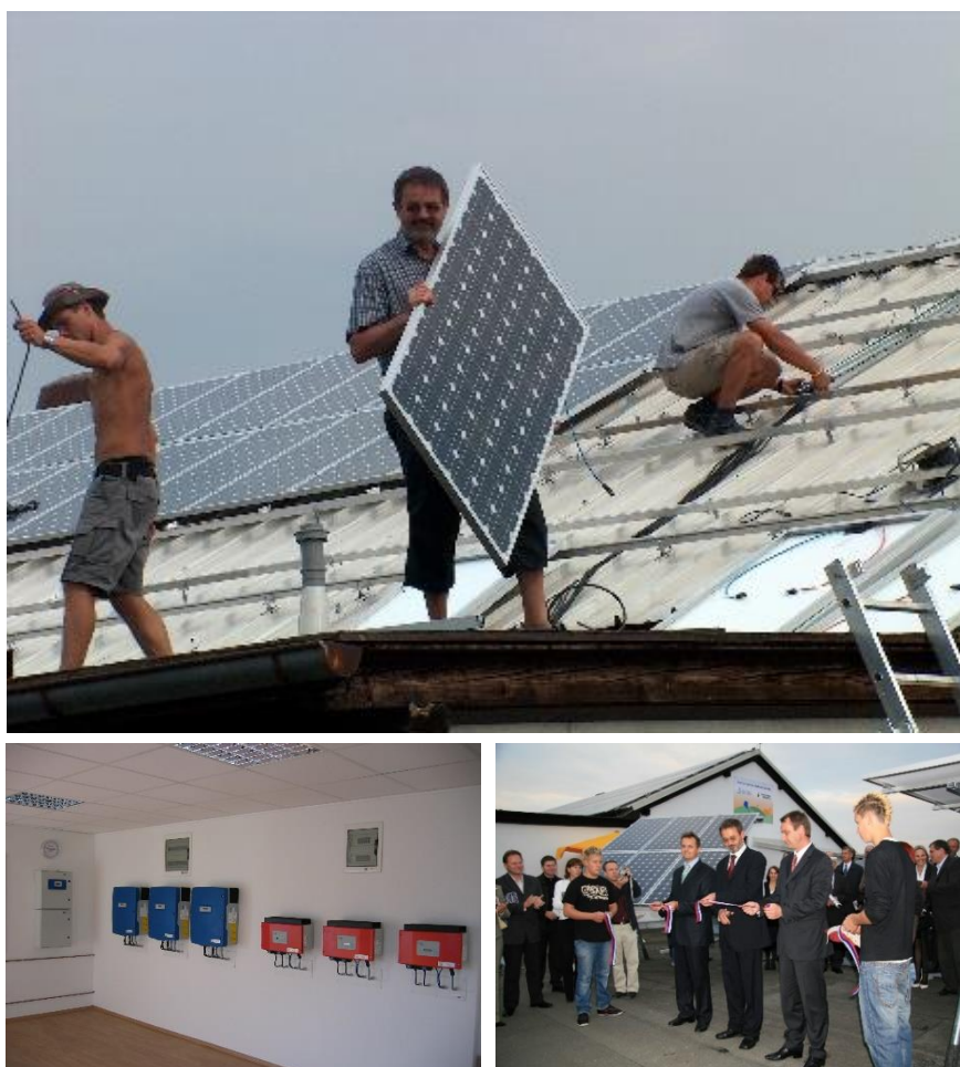
Montaža PV-generatorja in razsmernikov ter otvoritev sončne elektrarne SŠTS Šiška.
