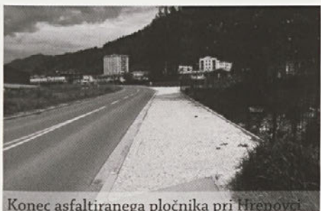
Konec asfaltiranega pločnika pri Hrenovci
