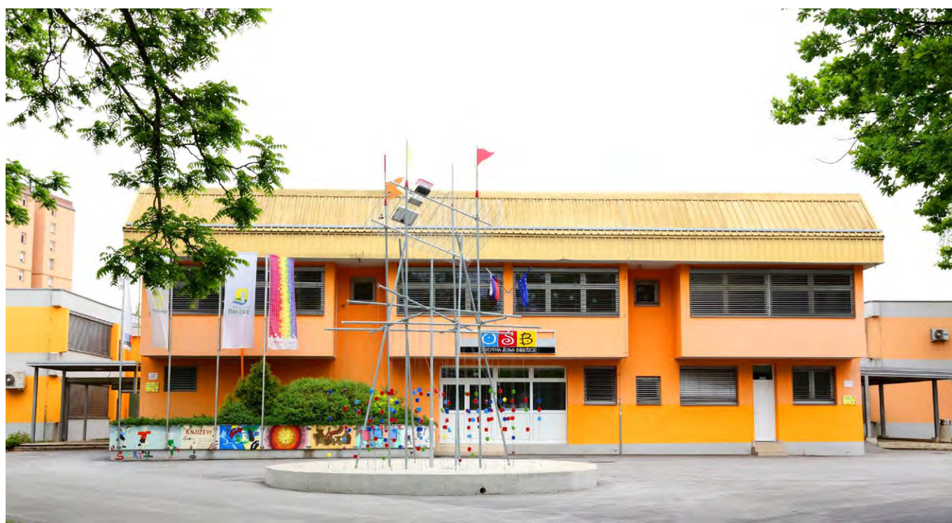
Stavba Osnovne šole Brežice (arhiv OŠ Brežice)
