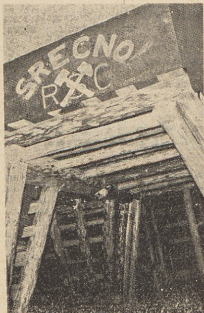
RŠC ZPT — podporje v leseni tesarbi za izvajanje A programa vajencev rudarske stroke (pri separaciji v Zagorju)
