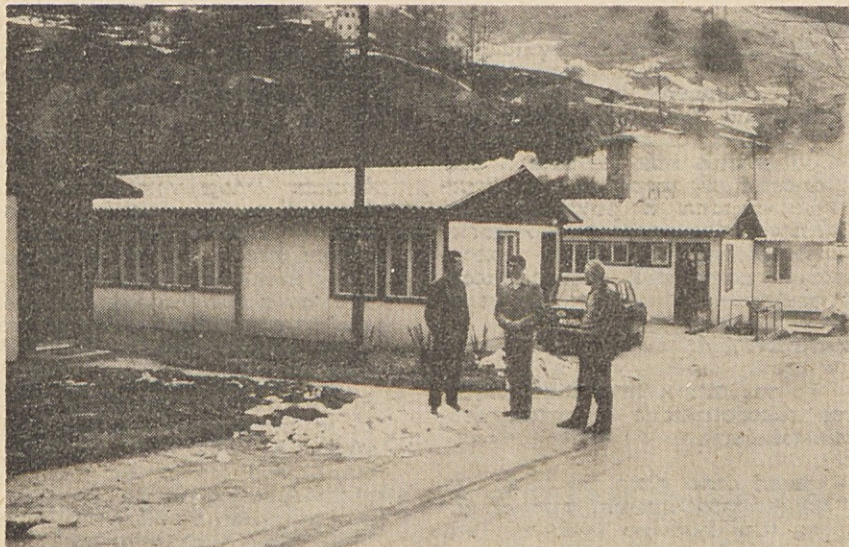
Stanovanjsko poslopje in kuhinja z jedilnico na gradbišču OSRD v Idriji Foto inž. Tone Bregant
