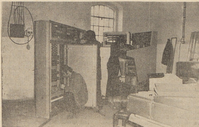
Šolska delavnica za vajence kovinarske in elektro stroke RŠC ZPT, v zgradbi bivše kompresorske postaje na Gvidi Foto inž. Tone Bregant
