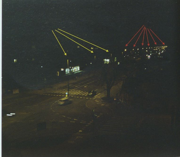
Slika 6. Delno zamenjana razsvetljava na Tržaški cesti v Ljubljani lepo pokaže, kakšna je razlika med okolju prijazno razsvetljavo, ki svetlobe ne pošilja po nepotrebnem v nebo (v ospredju označeno z rumenimi puščicami), in starimi, delno zasenčenimi svetilkami (v ozadju označeno z rdečimi puščicami). Svetilke v ospredju se ne bleščijo, saj ne svetijo nad vodoravnico, nad katero je bila posneta fotografija. Nezasenčene svetilke pa »slepijo«, čeprav so bistveno bolj oddaljene in so nameščene na enako visokih stebrih.
