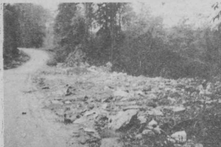
Odlagališče ob cesti na Polženo se nezadržno širi v gozd in tudi na samo cestišče. Kdo bo ustavil to barbarstvo nad našo naravo?
