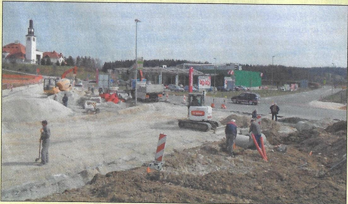
Pospešena gradnja krožišča v Ivančni Gorici
